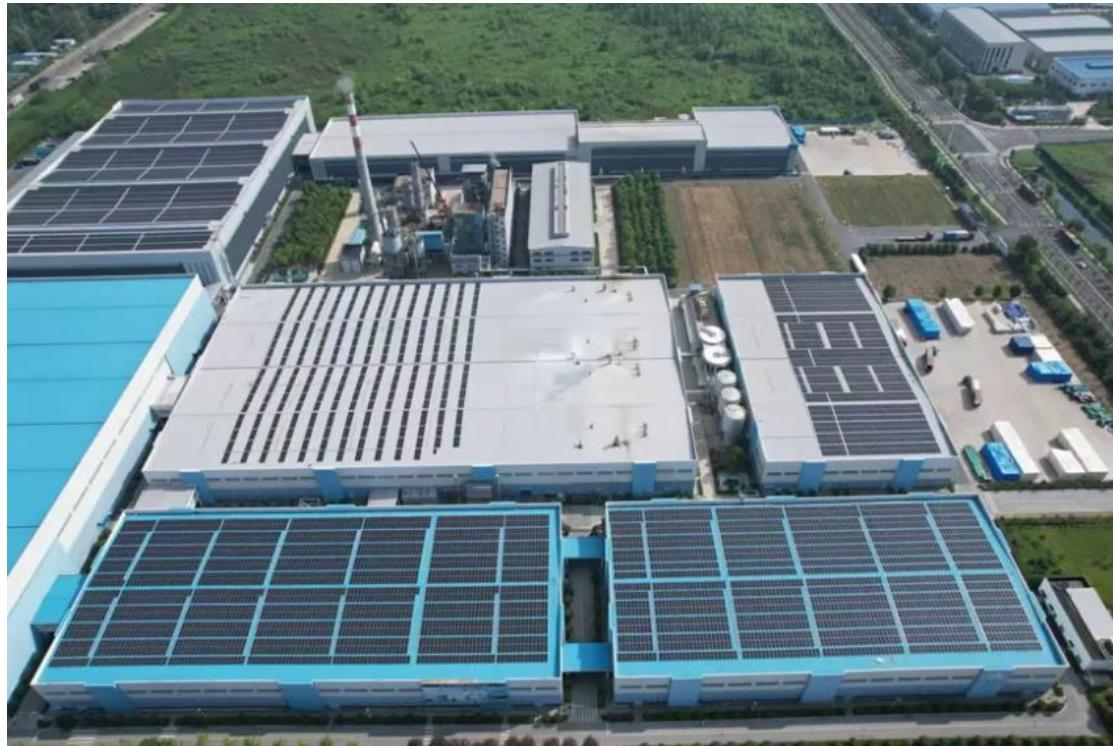
本项目充分利用维达护理用品（中国）有限公司五座厂房屋面，选用最新N型Topcon高功率620Wp双面组件，共计安装11774块，直流侧装机容量达7.29988MWp，通过接入22台华为组串式逆变器把直流电转换成交流电，经2台箱式变压器升压，最终以2座10KV开关站接入用户侧10KV母线。25年运行期间年均可为企业提供约739万千瓦时的绿电，并由维达护理用品（中国）全额自主消纳，可有效降低企业用电成本。
