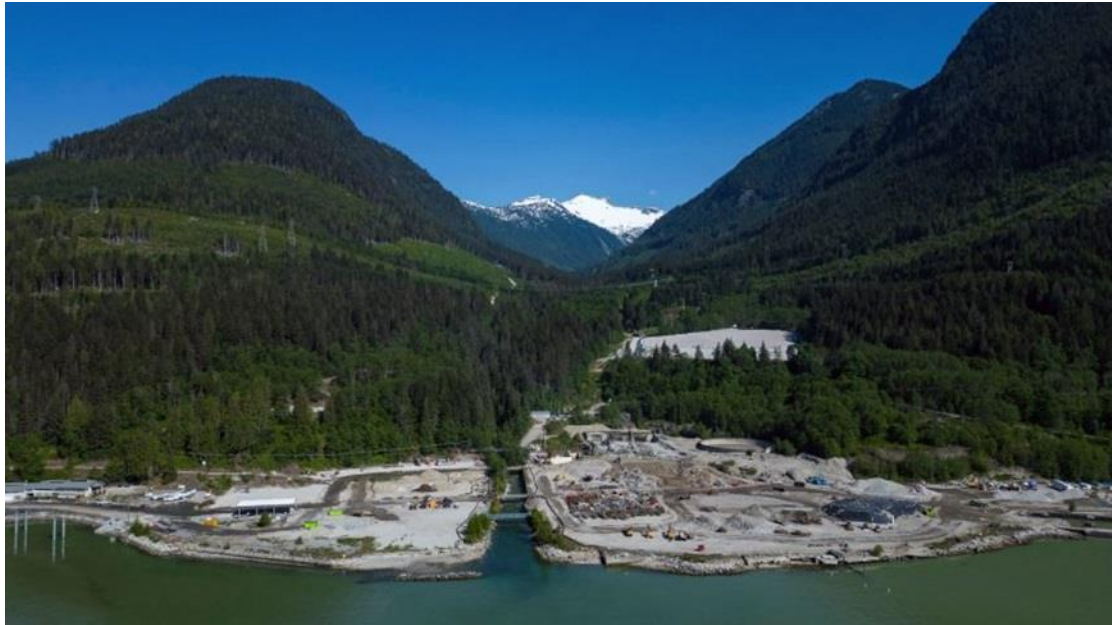
Woodfibre LNG 项目现场鸟瞰图
