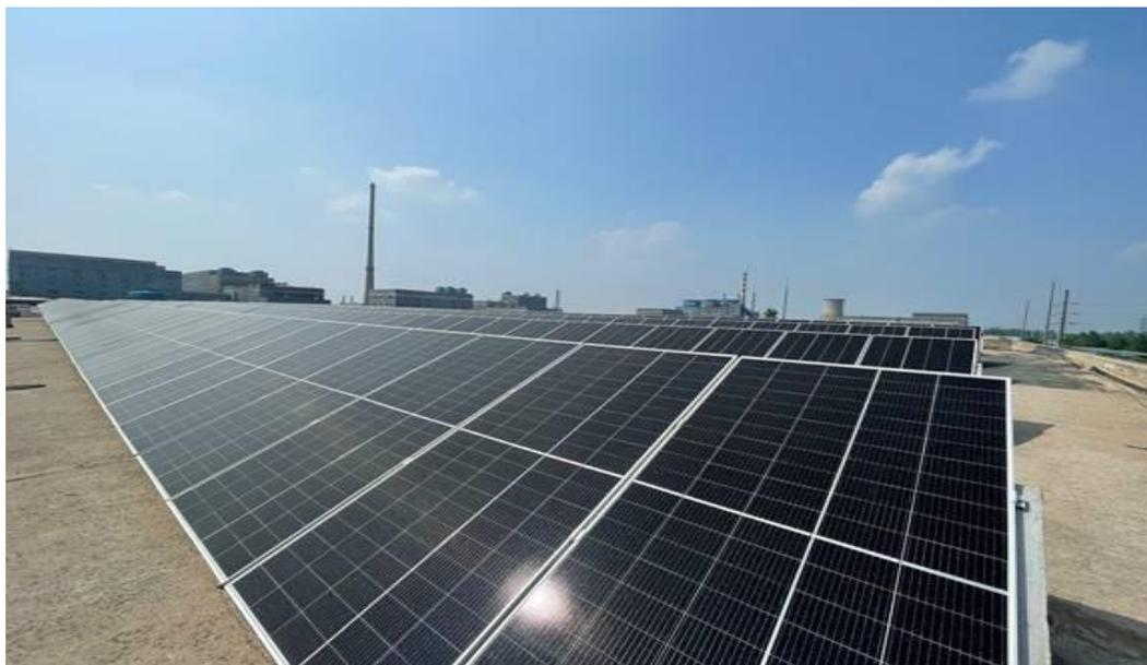
该项目位于江苏宿迁生态化工科技产业园内赛得利（江苏）纤维有限公司（以下简称“赛江苏”）厂区，总投资 500 万元，利用厂区仓库屋顶的闲置空间，采用倾角固定支架方式，由光伏阵列、并网逆变器、监控系统等设备组成。每年可提供可再生电力约 131.92 万千瓦时，相当于年节约标准煤 415.56 吨，减排二氧化碳 989.4 吨，减排二氧化硫 0.62 吨。所发电量够宿迁当地 1000 户城镇居民使用一年。
