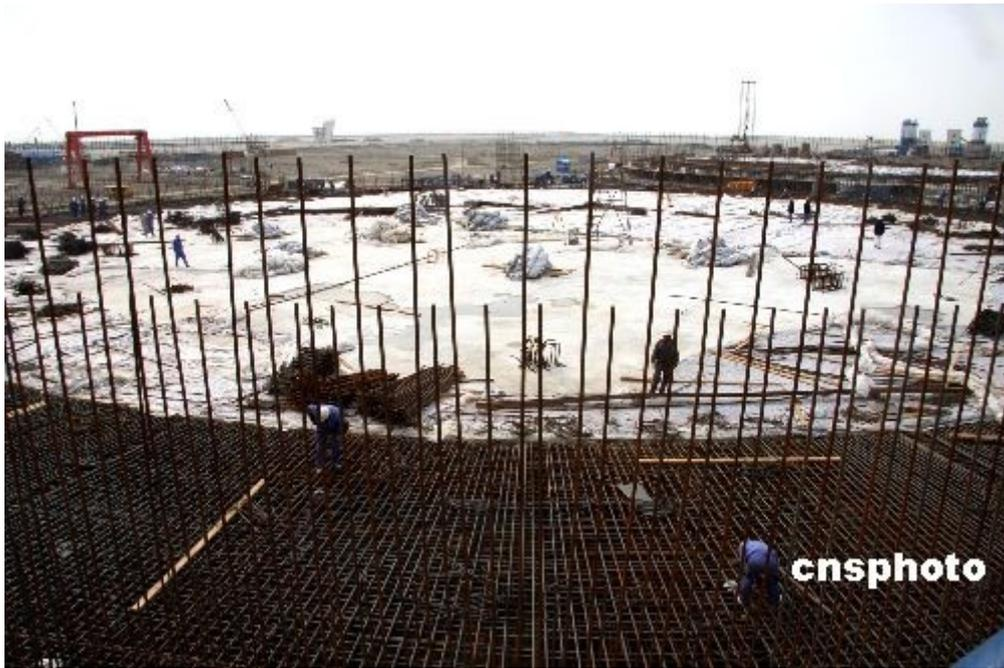
2月17日，在江苏如东洋口港太阳岛上，江苏省 LNG 接收站项目的 3 个大型储罐、单个罐区平台直径达 88 米承台工程已跃出海面，整个工程预计 2011 年投产。江苏 LNG 项目储罐基工程是国家重点工程——江苏 LNG 接收站工程的重要组成部分。这项工程远期规划为年提供天然气 135 亿立方米，目前正在建设的一期工程，年提供天然气 48 万立方米，由 3 座 16 万立方米 LNG 储罐以及相应配套设施组成。 中新社发 王必春 摄
